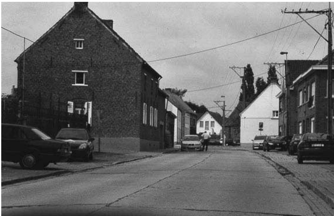
Links de woning tante Celle met aanpalend de lage werkmanswoning Dikke Marie
